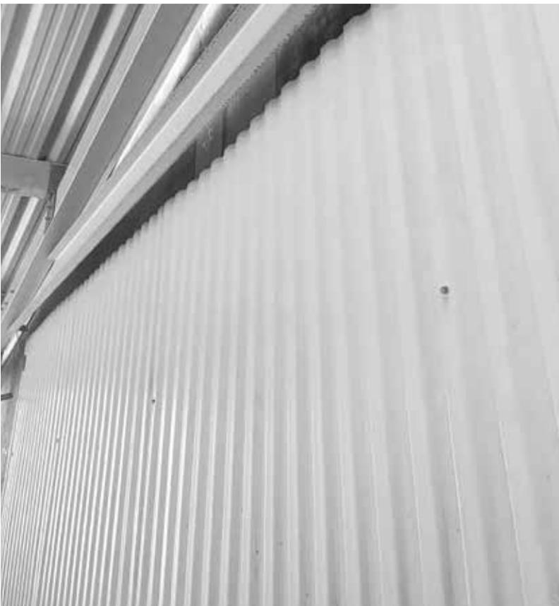
PESO LIGERO 5 KG/M<sup>2</sup>, AISLAMIENTO ACÚSTICO Y TÉRMICO 40%, 100 KG DE CARGA PUNTUAL CON CARRIOLAS ENTRE 60 - 90 CM DE DISTANCIA, PROBADA CON FUEGO, AGUA, HUMEDAD Y CORROSIÓN, CERTIFICADA POR ISO9001 E ISO14001.
